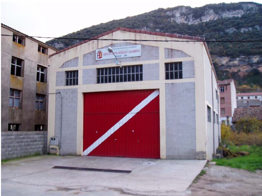
Pabellón de bomberos en la Crta. Tamayo, s/n
